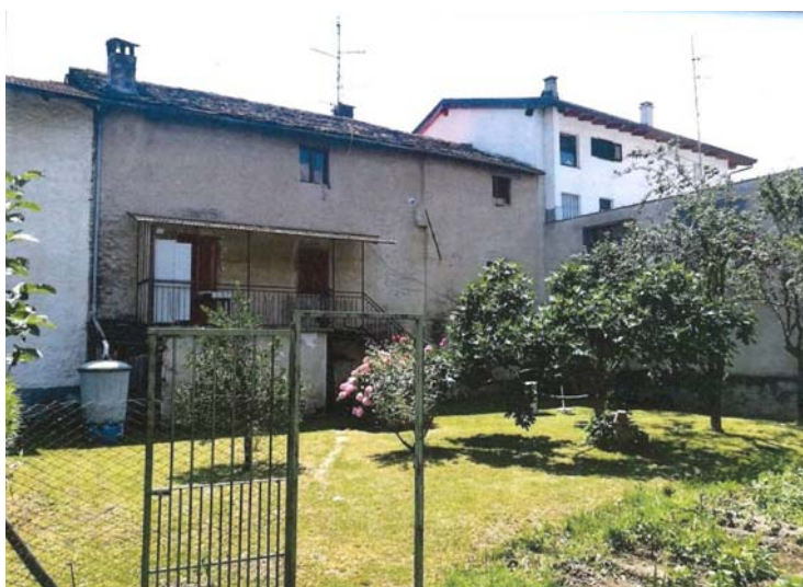
Edificio residenziale su cortile interno –prospetto nord
