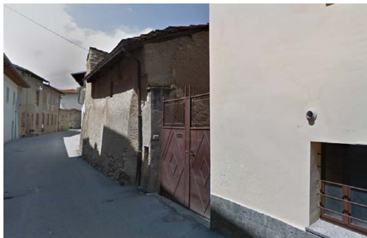
Edificio su Via Cariolo, vista lato est (da Google maps)
