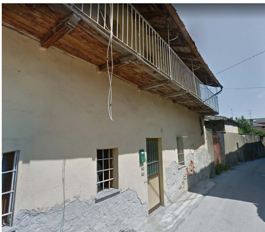
Vista da Via Cariolo, lato ovest (da Google maps)
